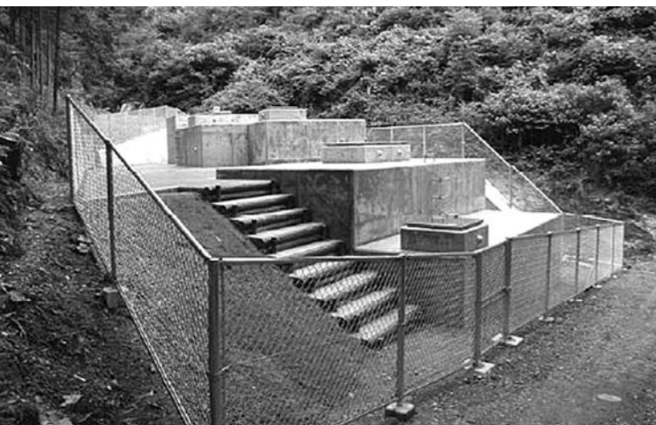
塩素注入を除き無電源での運用が可能な浄水場
