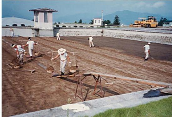
図8 砂面汚泥の削り取り作業
