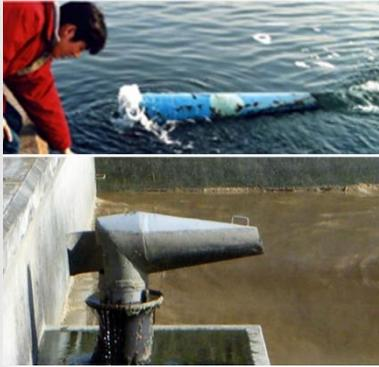
図18 ろ過池水面を凍結させない工夫
