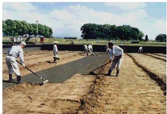
図24 浅いろ過池での削り取り作業
