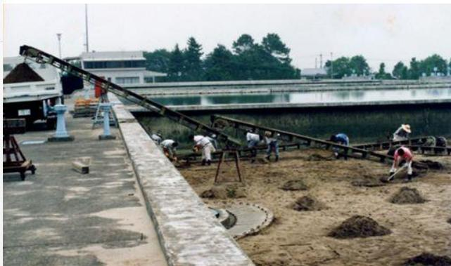
図23 深いろ過池での削り取り作業
