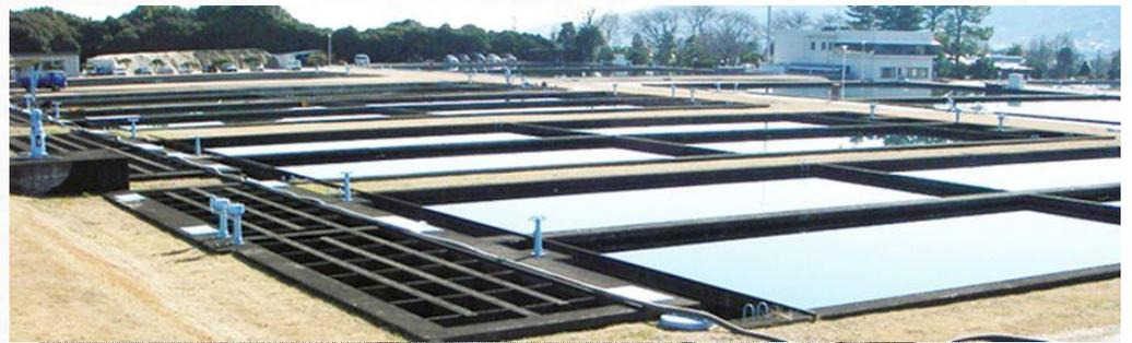
図20 若田浄水場の混和池と沈殿池
