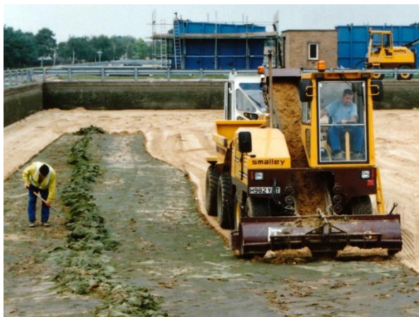
図3 削り取り作業が困難な糸状緑藻の繁殖（ロンドン）
