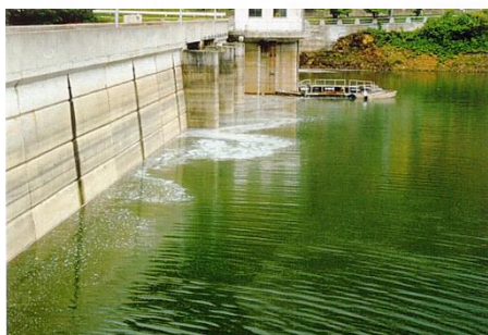
図5 下水処理水がダム堰堤際へ流入し直ぐに放流される
