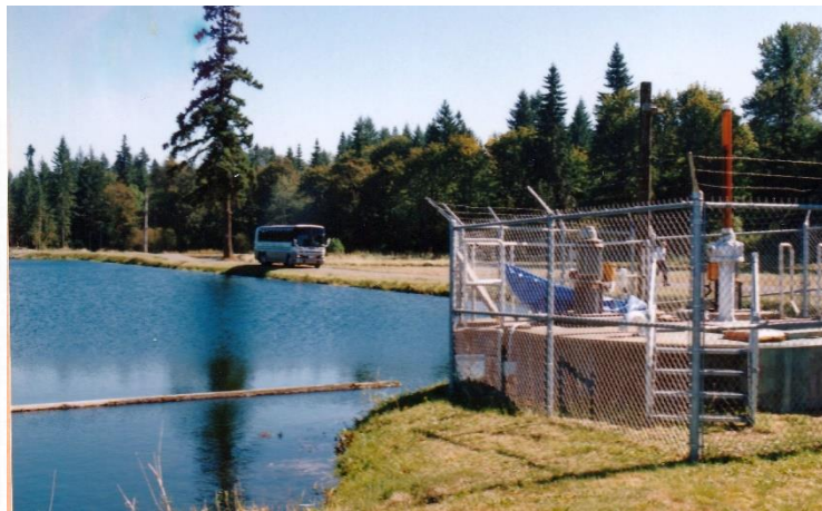
図15 ジラン浄水場沈殿池
