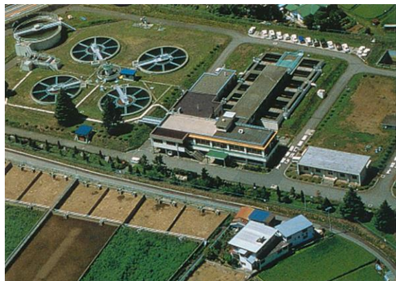
図2 クリプト事故前の急速ろ過の浄水場
