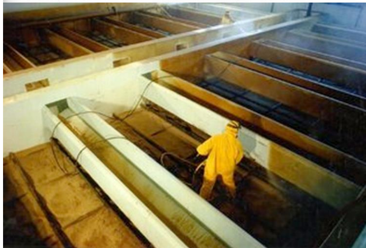
図11 急速ろ過池を徹底的に洗浄
