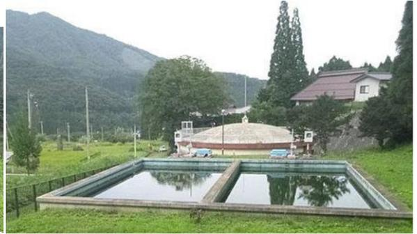
図38 ろ過池と浄水槽しかない西原浄水場
