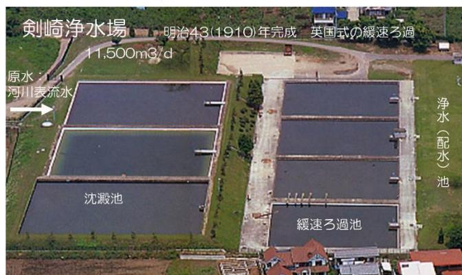
図11 沈殿池と砂ろ過池だけの剣崎浄水場
