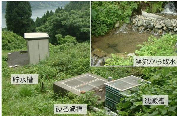
図12 別荘地用の手作りの小規模浄化施設
