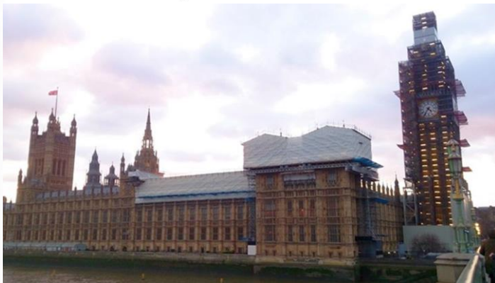
図26 英国国会議事堂は補修工事中でも使い続けていた
