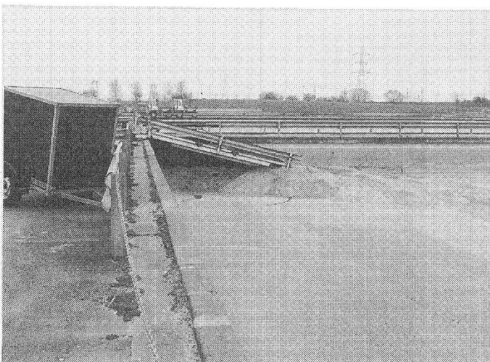
写真13 使用中の移動式スロープ（カッパーミルズ 浄水場）
