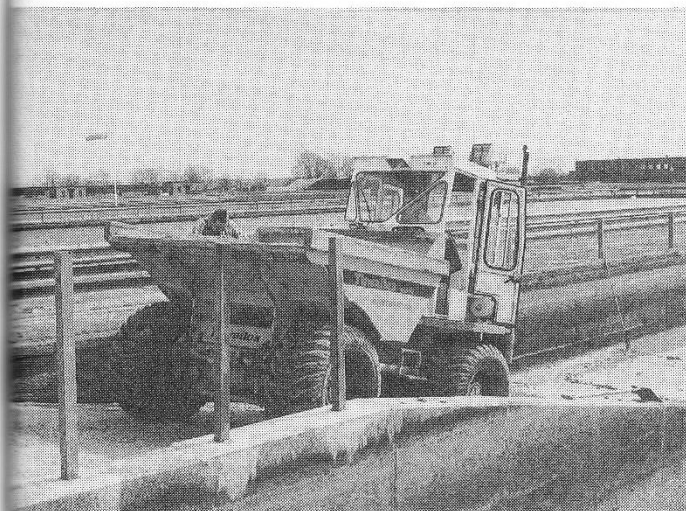
写真12 ろ過池のコンクリートスロープと砂運び 運搬車（アシュフォード・コモン浄水場）
