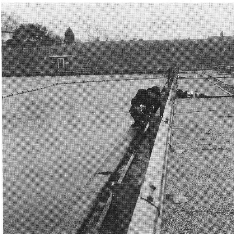
写真5 大型の機械式削り取り装置移動用レール（現在は使用されていない）のそばで調査する筆者。その右は作業用自動車落ちないためのガードレール。ろ過池に浮いているのは吸引削り取り船の吸引ホースである。
