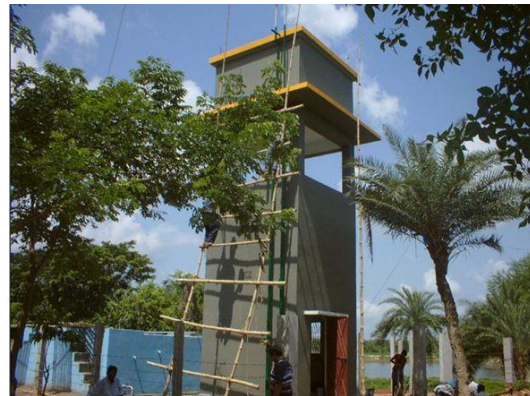
図23 給水槽および原水槽塔
