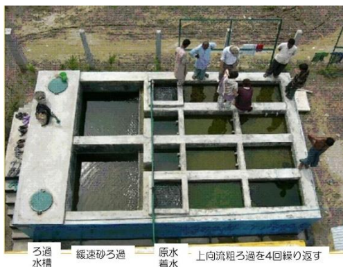
図24 塔から見た浄化装置
