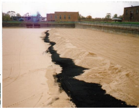
図42 砂層に活性炭層を挿入試験
