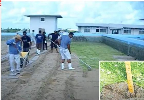
図18 砂面の削り取り
