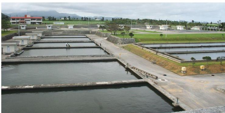
図8 石垣浄水場のろ過池
