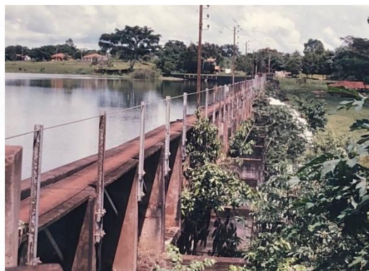
図5 ブローア湖堰堤
