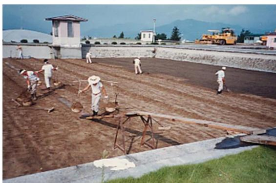
図28 砂面の削り取り作業
