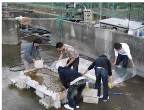
図25 合板の培養槽の作成
