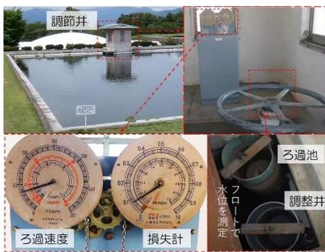
図38 染屋浄水場の水位差と流量測定
