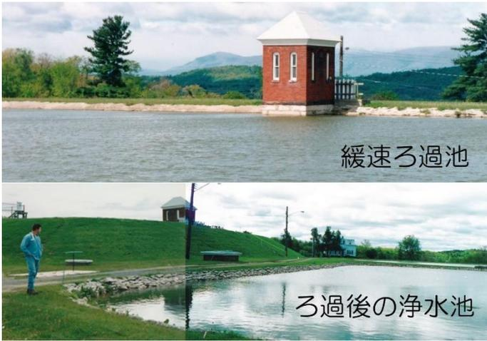
図7 浄水池に覆いが無い1872年から稼働している浄水場
