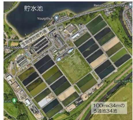
図10 カッパーミル浄水場
