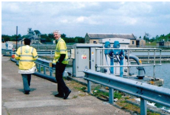
図22 ろ過池を見学
