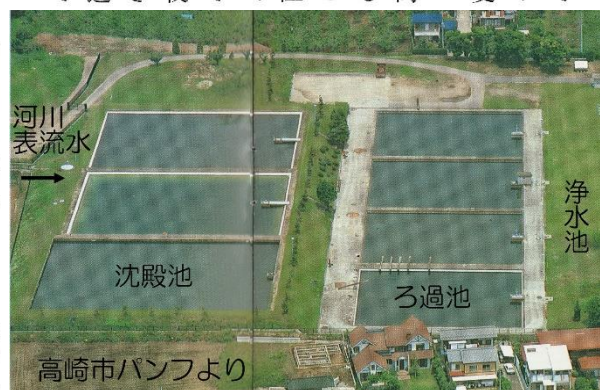
図4 剣崎浄水場(明治43年)
