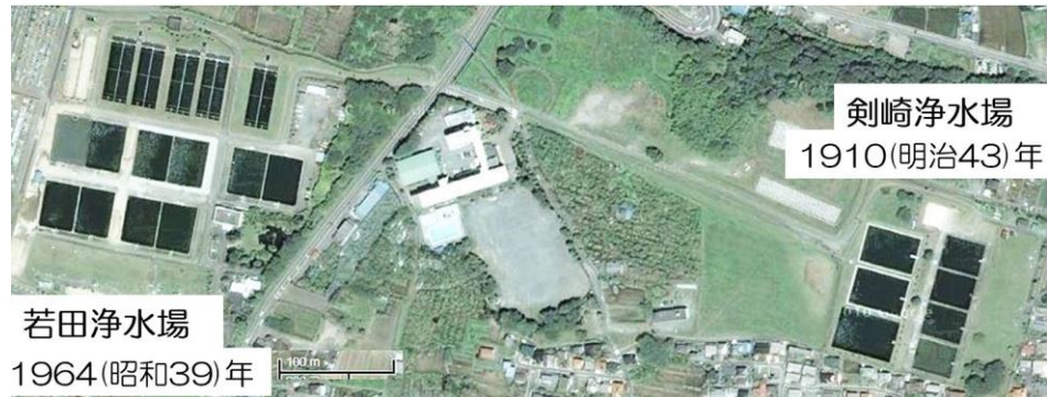
図36 高崎市の緩速ろ過の浄水場
