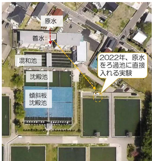
図32 原水を直接ろ過池への実験
