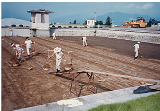
図18 砂面の削り取り作業
