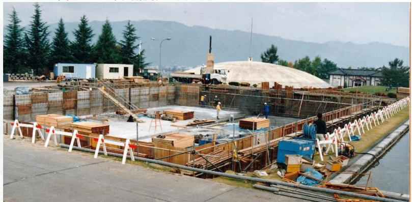
図33 漏水しやすい垂直壁にした
