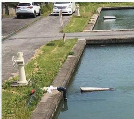
図14 ろ過池へ直接に導入
