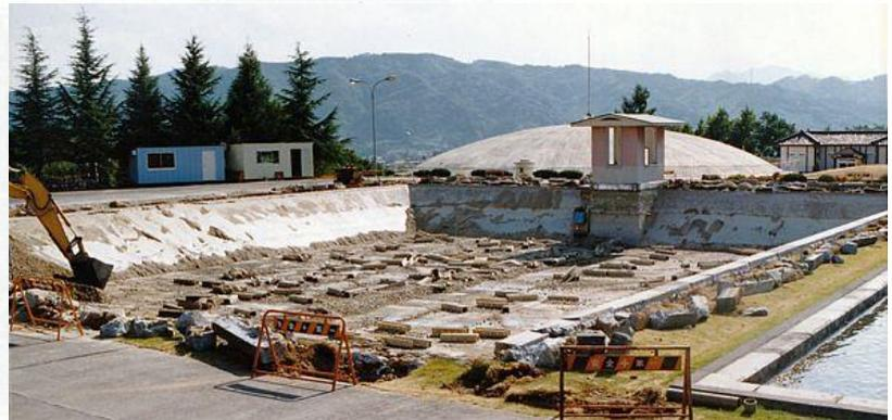
図32 92年、耐震性の良い斜め壁のろ過池を更新
