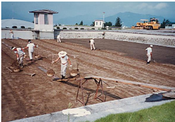
図15 砂面の削り取り作業
