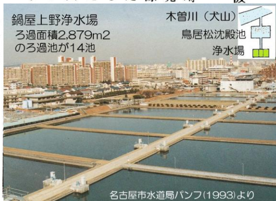
図24 鍋屋上野浄水場
