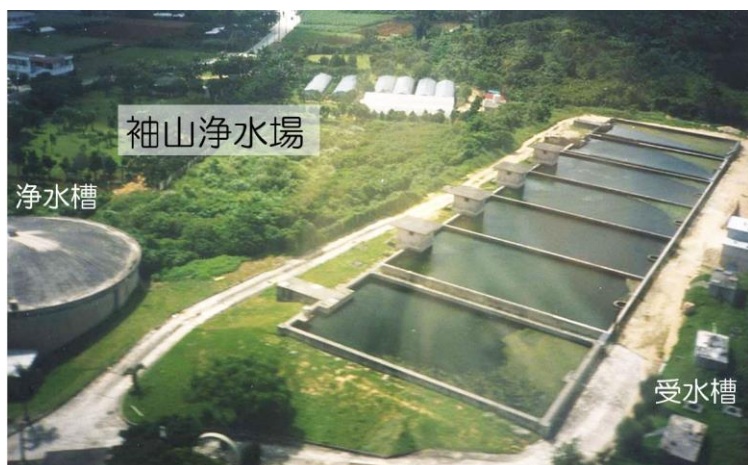
図4 宮古島の袖山浄水場
