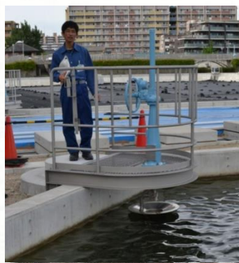
図11 改良した越流管
