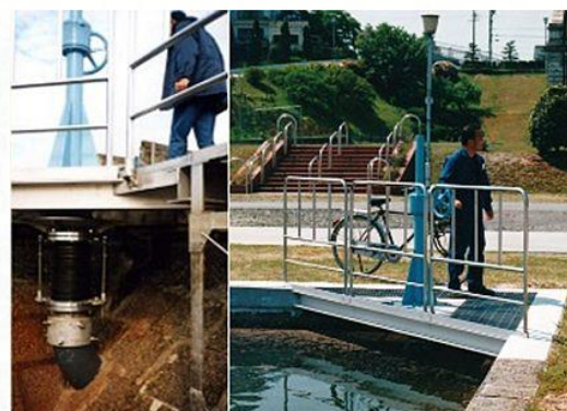
図9 改良した越流管
