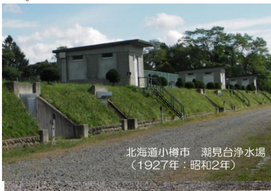
図25 小樽市の覆い緩速ろ過池
