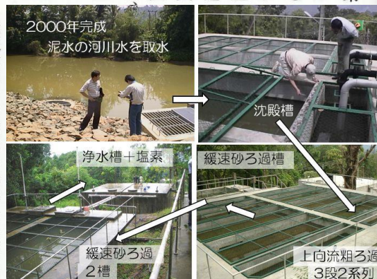
図19 スリランカでの浄化槽
