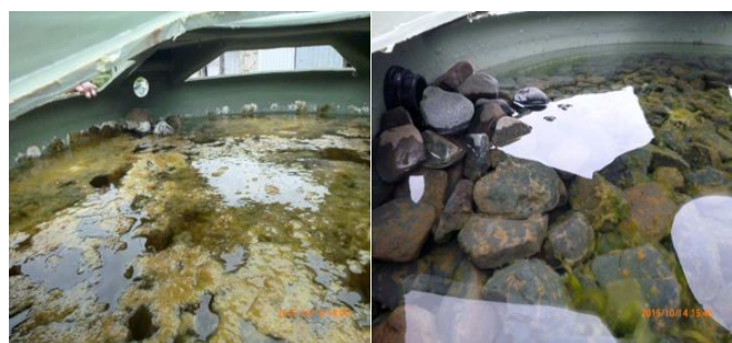
図 19. 粗ろ過槽での藻の繁茂と消失
