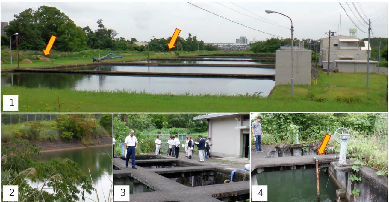
ろ過池の奥に削り取った砂山があった（1）。その量はわずかであった。水源貯水池の壁面は、水位変動があるのでコンクリートブロックで補強されていた（2）。コンサルによる診断では貯水池は耐震性を満足すると記載されていた。貯水池水面が着水井より低いのでポンプ揚水をしていた。貯水池の水を取水井に導水しポンプで着水井へ送水する仕組みであった（3）。取水井には廃棄されたパイプがあり質問したところ、以前は殺藻剤を添加していたが現在は使用していないとのことであった（4）。
