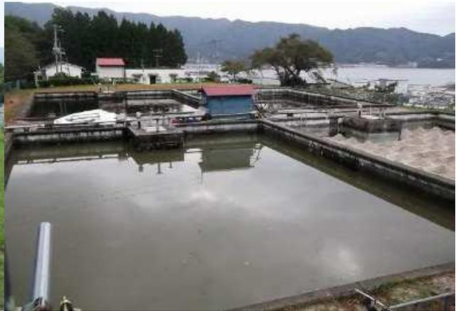
図23 ろ過池 RC 構造 (20m×15m×2.5m)
