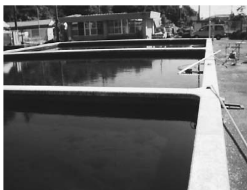
図2. H県にある浄水場は隣の河川に有孔管で濁りがない水を取水していた。濁りがない原水なので、ろ過池だけという浄水場である。濁りが無ければ、ろ過継続は長くできる。半年以上ろ過継続しても目詰まりしない。糸状の緑藻や珪藻が繁殖していた。
