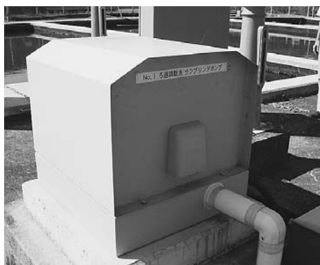
図10. 原因は、濁度計に導水するための、採水ポンプであった。本来、濁度は、細菌などの濁りを測定するものである。便宜的に濁度で測定しているのである。そこで、細菌を測定してみたらどうかと勧めた。急速ろ過処理では、藻類が関与しないので、溶存酸素が過飽和になるということはない。
