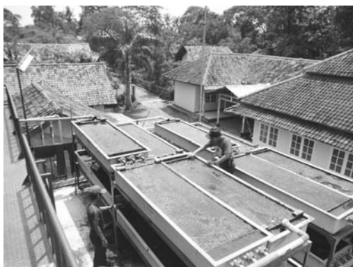
図 36-2. 灌漑用水を汲み上げて、屋根の上の水槽に水を導水する。浅い水槽では、太陽の日射で藻が繁殖するが、ブラシ状のヒモが何本も張ってあるので、流されない。藻が繁殖するとヒモと藻の周囲には微小動物が増える。この動物がシルトなどの濁りを食べて糞塊にして沈める。底に沈んだ糞や濁りは、底から排出する。増えすぎた藻も時々、取り除く。濁りが無くなった水は、緩速ろ過用の水になる。
