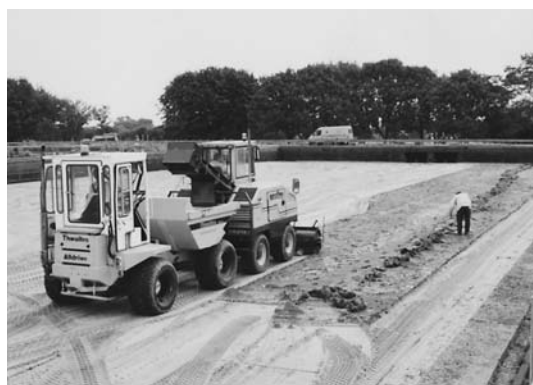
図 19. テムズ水道では、砂層表面の削り取りは機械化をしていた。夏は、砂層面には糸状緑藻クラドホラが目立っていた。通常の削り取り機械では、取り除くのが大変で、「やっかいな藻」として嫌われていた。
