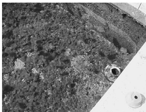
図4. 一番調子が良さそうなろ過池の砂層表面では糸状珪藻のメロシラが繁茂し、光合成により生じた気泡の浮力で浮き上がり、底には砂の面がパッチ状に見え、そこは藻類被膜が剥離した場所である。
