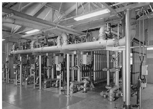
図 32. 急速ろ過処理では、クリプト原虫は通過してしまうので、膜処理を導入する施設が建設されだした(埼玉県越生町の浄水場パンフより)。莫大なエネルギーがかかり、維持管理経費が莫大である。借金の原因になる。省エネが緊急課題であるのに逆行している。
