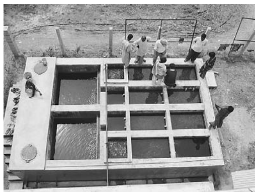
図35. 地下水中のヒ素汚染で悩むバングラデッシュで、乾期でも水がある三日月湖の表流水を取水し、水道施設を建設したいと言われた。また、農業もお金をかけずに除去できる装置を考えてと頼まれ、上向き粗ろ過を何回も通して生物のお腹を何回も通過させる方法を考えた。最後に緩速ろ過処理をする。後で、冷静に考えてみると、日本と比べても、農業の使用量は余り変わらなかった。バングラデッシュで国民のための緩速ろ過施設としては初めての施設ができた。
