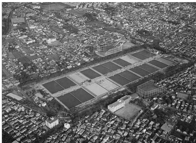
図1. 緩速ろ過処理では日本一の浄水能力の東京都水道局境浄水場。貯水池水源なので、濁り水対策は必要ないので、ろ過池だけである。污泥処理もほとんど必要ない。薬品処理、機械設備も必要ない。これなら、省エネである。大正13(1924)年完成で、80年以上造りかえもせずに使い続けている。これなら、原価消却はとくに済んでいる。維持管理費は少なく、正に省エネで、21世紀への持続可能な施設ではないであろうか。でも良く見ると、この水道局のパンフレット写真では、どういう訳か、写っているろ過池に水が入っていないろ過池が4分の1もある。
