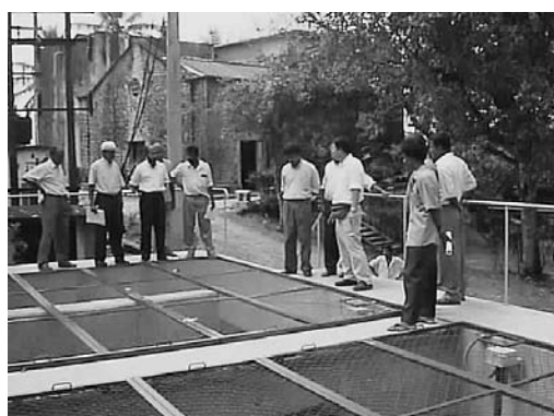
図34. 熱帯で泥水がくる様な河川表流水を取水し、沈澱池、上向きの粗ろ過槽を通して、緩速ろ過処理をする施設がスリランカにできた。現場監督がナチュラルフィルターと言ってくれた。6年後に訪れたが、まだ、問題なく健在で稼働していた。発展途上国に行くと、技術援助で最新技術施設を建設するが、数年で使えなくなっている施設が目立つ。相手の国で、自力で維持管理、修理ができる施設を援助建設するのが本当の意味での国際貢献であろう。
