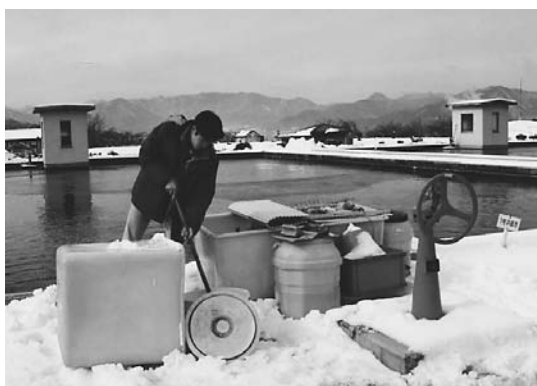
図 29. そこで、実際のろ過池で、夏の栄養塩濃度より少し多い程度まで増やしてみることをした。実際に飲む水道水をつくるろ過池であるので、保健所長に相談した。試薬特級より値段が高い試薬の食品添加用の試薬を購入した。日本で一番、信頼されている薬品会社の試薬を購入し、添加する実験をした。これでもか、これでもかと肥料成分を加えたが、藻は増殖しなかった。問屋から関東平野中の食品添加試薬は無くなったから、関西から取り寄せるとの問い合わせまできた。2月から3月にかけて実験をしたが、結果はマイナスであった。
