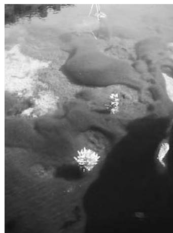
図6. 隣のろ過池では、砂層面に糸状緑藻スピロギラ(アオミドロ)が繁茂していた。糸状緑藻も光合成による酸素の気泡の浮力で浮き上がるので、砂面も見られた。また、ろ過継続が長い証拠に、底には維管束植物の水草が成長していた。
