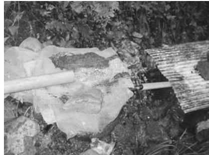
図 116-1. 山の中腹で谷の水取水し、その水を網戸の網を利用してゴミをとり除く仕組み。勢いがあるので、ゴミなどは押し流されてしまう。
