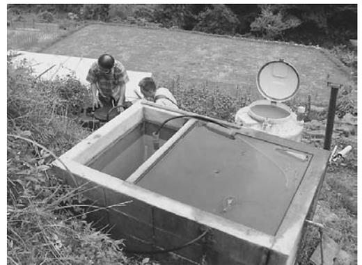
図 117. 渦をつくって濁りを自動的に除くろ過槽。実際は、トタンで覆っている。
