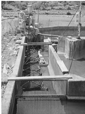
図 111. 徹底的に濁り除去をするために、水路に網目 1 ミリ程度の野菜用収穫ネットを多数敷き詰め、粗ろ過効果を期待した。人工の伏流水を考へ、ネットの上に、暗幕で暗くした。
