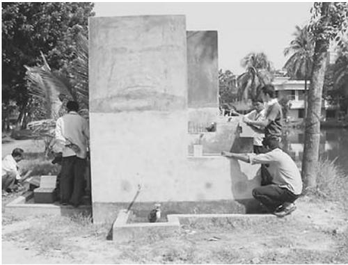
図 127-3. 最上部には1日分の使用量(1.2トン)の貯留槽。3段の粗ろ過槽に1槽の砂ろ過槽を常に流れるように工夫した。現地では数軒分の必要量が賄えるモデルが完成した。汚れた池の水でも造って1ヶ月で大腸菌もでない安全な飲料水ができるようになった。
