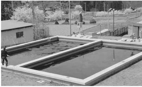
図 102. 長野県須坂市には、山裾で小川の横でヨシが生えている場所に有孔管を埋設し浅い伏流水を原水とする西原浄水場ある。濁りがほとんど無いので、緩速ろ過池は稼働を開始してから2年間一切何もしないで良質のろ過水を供給し続けている。
