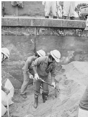
図 124. 凝集剤を一切使用していないかった浄水場である。砂層深く掘ってみたが、一切、砂泥は砂層内部に侵入してはいなかった。創設から80年経過したが、天地替えなどを一切していなかったが、砂層は汚れてはいなかった。天地替えは、凝集剤を使用したり、生物毒を入れたりする浄水場で、必要な作業である。本来は必要ない作業である。
