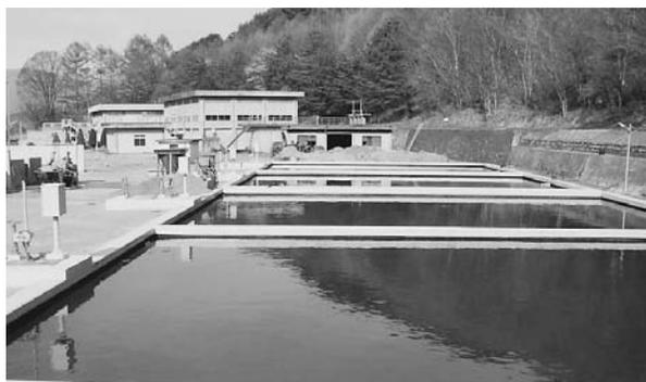
図 88. N 県の浄水場で、河川表流水を取水し着水井で、殺藻目的で、次亜塩素酸ソーダを常時注入している。ろ過池の脇に行くとい塩素の臭いがする。河川水が濁ると凝集剤を添加するようにしている。
