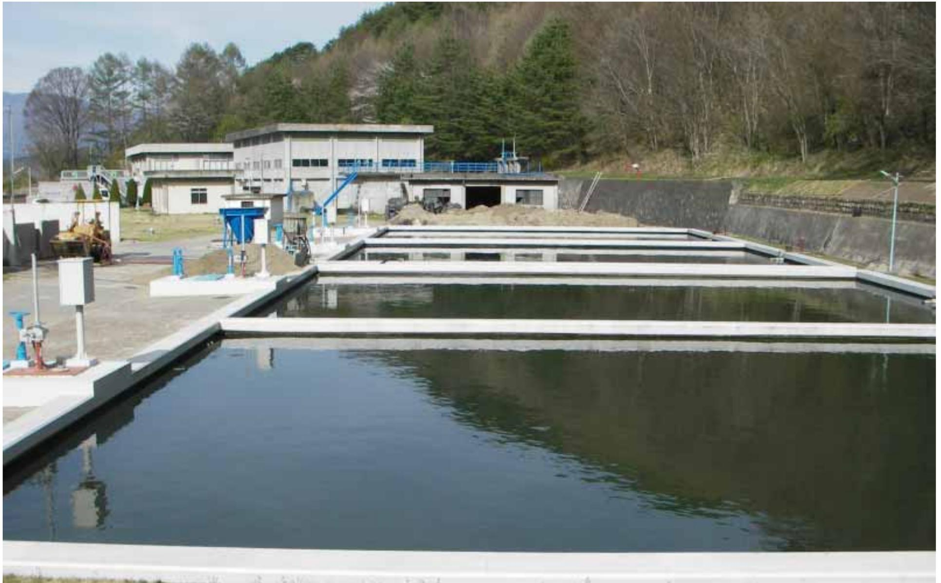
上田市腰越浄水場: 河川表流水取水、殺藻剤(次亜塩素酸ソーダ)添加。攪拌、沈殿後、緩速砂ろ過(機械的なる過)。ろ過速度約3 m/d.1ヶ月以内に損失は約60 cm。某有名水道メーカー関連会社が維持管理。
