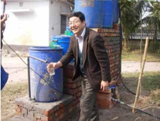
2006年12月末、バングラデッシュで、小型生物浄化装置をつくった。1日給水能力0.5トン、バングラでは、一人1日10リットルは飲み水と調理。それなら、50人分、10家族分である。電動ポンプで1日2回だけ汲み上げるだけ。ろ過水を溜めるポリタンクが必要だが、帰国まで調達できなかった。
