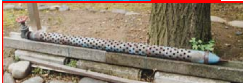
東京都砧浄水場の多摩川の河原に埋設した集水井と有孔集水管
