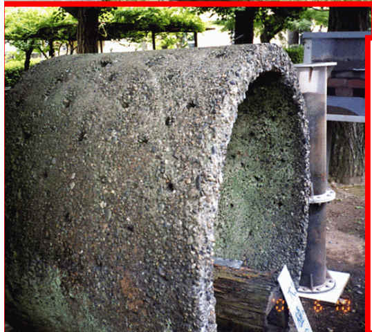
東京都砧浄水場の多摩川の河原に埋設した集水井と有孔集水管
