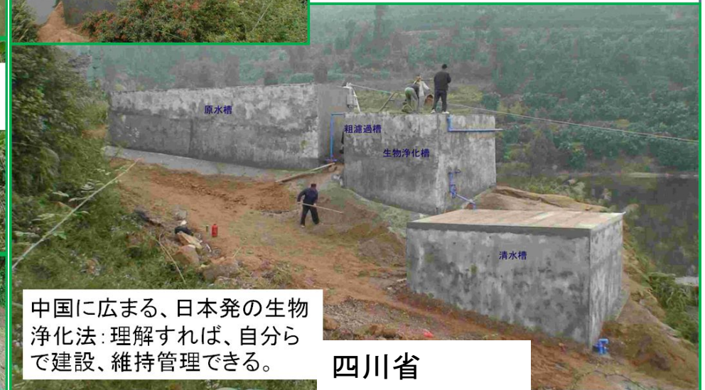
池の水、原水槽、粗ろ過(下向きから上向き)、生物浄化槽、清水槽
