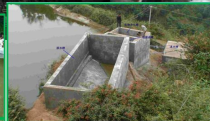
池の水、原水槽、粗ろ過(下向きから上向き)、生物浄化槽、清水槽
