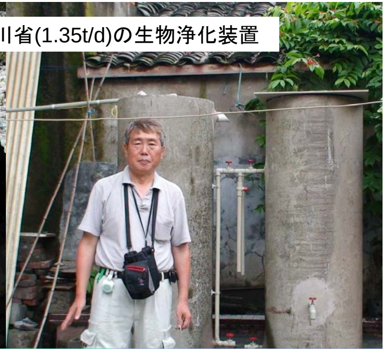
池の水、原水槽、粗ろ過(下向きから上向き)、生物浄化槽、清水槽
