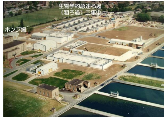
図7 前処理施設建設中
