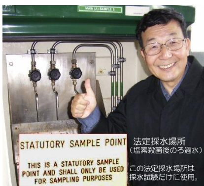
図12 給水前の試験採水栓
