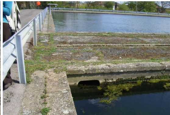
図9 ろ過池の越流口
