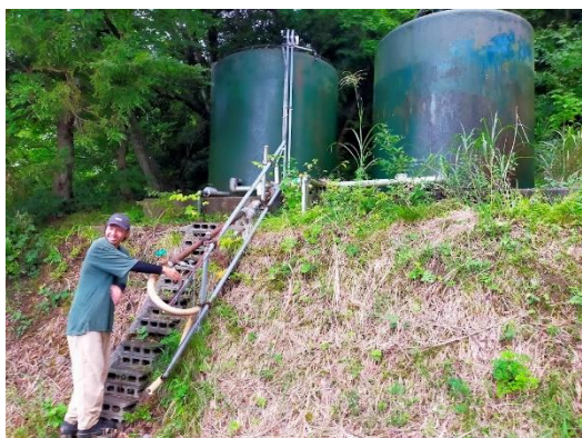
東山中飲用水供給施設（東山中町）のろ過タンク（左）と減菌施設（右）。
