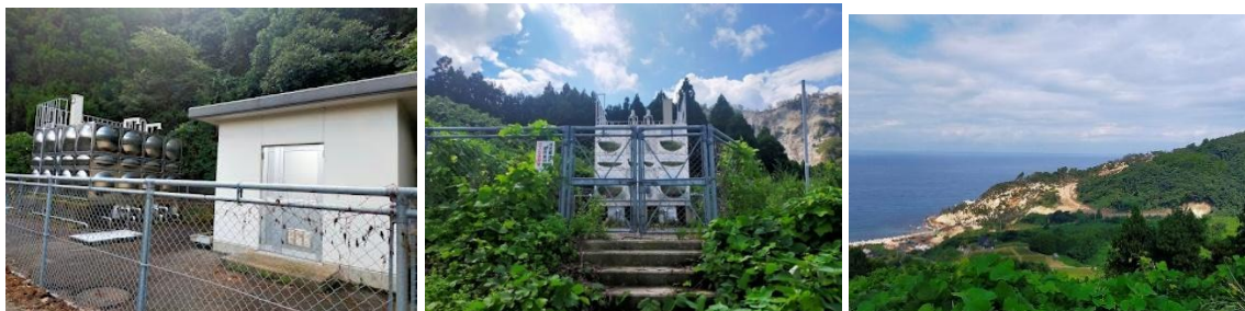
上左：第1の貯水タンクとポンプ室。上中：さらに高い位置にある第2の貯水タンク。上右：第2のタンクは高台にあり、土砂崩落した仁江町方面が見渡せる。
