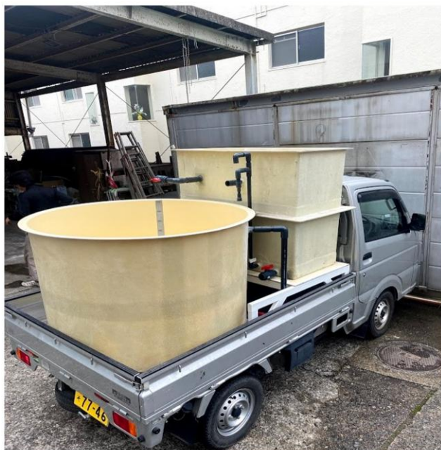
軽トラに積載可能な大きさで濾過池用の容器と貯水タンク用の容器を作成しています。
