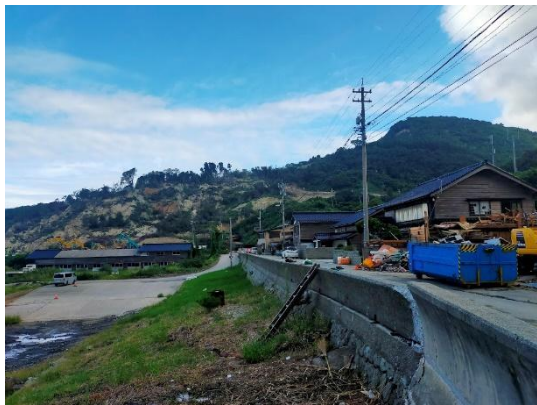
上左：まだら状に崩落しているのが、隣の仁江町と境をなす山地。トンネルも埋まり通行できない。 上右：地盤が凸凹になり室内が傾いて住めなくなった住宅。
