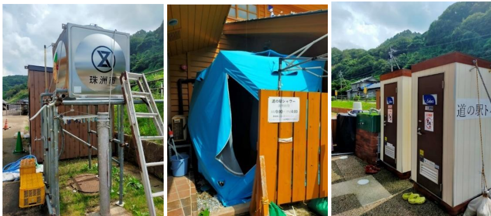
公共施設・道の駅の水関連の応急施設。左から珠洲市設置の給水タンク、WOTA の可搬式シャワー施設、エアコン付き仮設トイレ。
