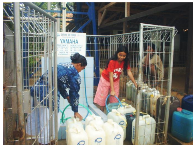
図 9. 共同水栓方式で給水管理
