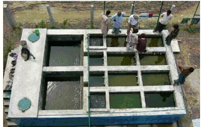
図 18. 上向き粗ろ過を4回繰り返す浄化装置
