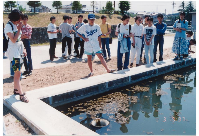
図3. 浮いてきた藻は越流管から流出していた
