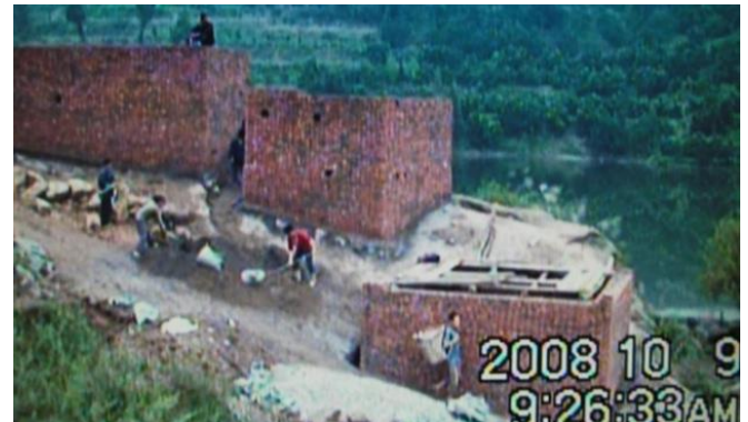
図23. 建設の速度は驚くほど速い
