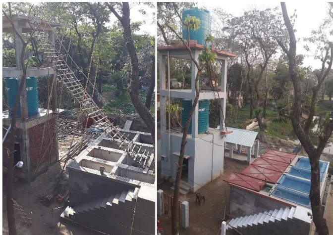
図20. 2019年にはユニセフ基金で新たに建設
