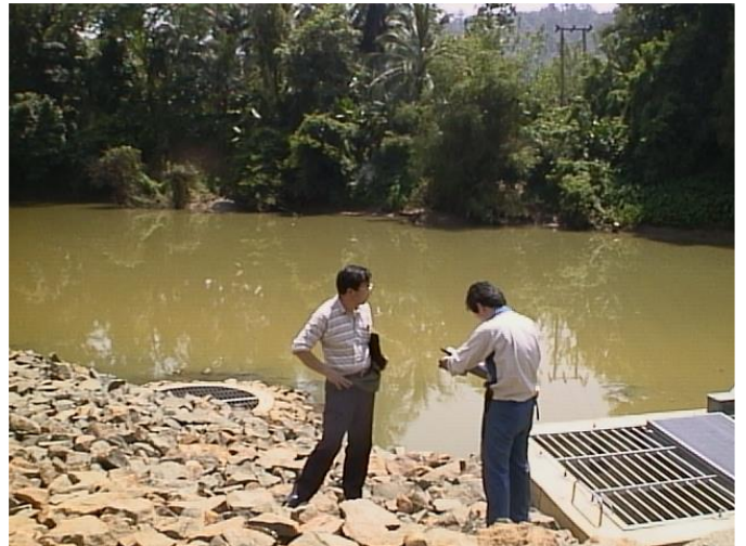
図 13. 熱帯河川の細かな泥水が水道原水
