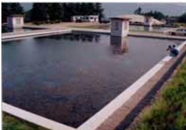
*Fig. 82.1-O tanque de filtração lenta da Cidade de Ueda tem 780m<sup>2</sup> de área. Esse tanque fornece 3.900m<sup>3</sup> de água potável por dia. Observam-se algas flutuando na superfície da água. Isso é uma prova de que os seres vivos estão em plena atividade.*
