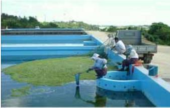
*Fig. 39.1-Com a interrupção do lançamento de algicida, houve um grande aumento de algas no tanque de filtração. Mesmo no tratamento ecológico, há necessidade de remover as algas que emergem na superfície da água.*
