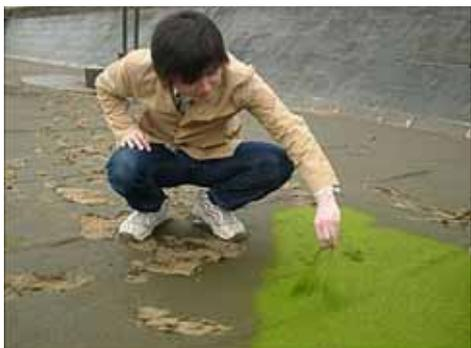
*Fig. 62.1-O uso prolongado de filtração provoca o aparecimento de algas de cor verde. Contra a correnteza, crescem algas verdes filamentosas (Spirogyra, Hydrodictyon, Cladophora Oedogonium, etc). Durante o trabalho de raspagem da camada superior de areia dos filtros, pegando-as com a mão, constata-se que elas são de fato duras.*
