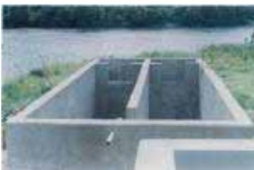
*Fig. 75.1-Fase de construção do tanque de captação da água do Rio Niger.*
