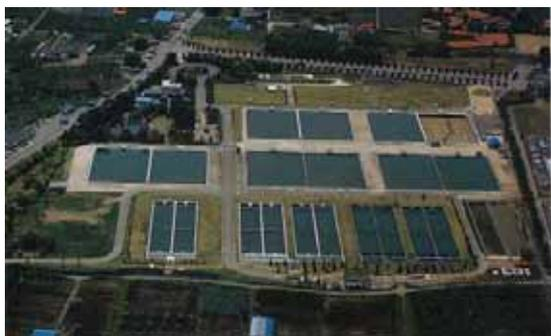
*Fig. 12.3-A Estação de Tratamento de Água de Wakata, construída em 1964, foi inicialmente projetada para utilizar coagulantes químicos, a fim de retirar partículas sólidas em suspensão. Hoje, mesmo que a água esteja bastante suja, o processo de sedimentação é feito sem a adição de coagulantes.*
