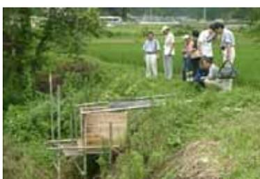
*Fig. 86.3-O arrozal foi transformado num tanque de precipitação. A água é filtrada numa caixa de filtração lenta. Essa instalação fornece  $5m^3$  de água tratada por dia, volume suficiente para o consumo de 17 pessoas (considerando um consumo per-capita de 300 litros por pessoa por dia).*
