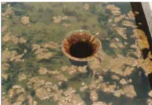
*Fig. 31.1-As algas que crescem na superfície de areia do meio filtrante sobem à superfície da água juntamente com bolhas de gás oxigênio, durante o processo de fotossíntese. As algas que sobem à superfície são automaticamente drenadas para o canal de descarte.*
