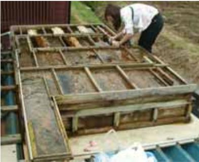
*Fig. 87.1-Mesmo água com cheiro de gás sulfídrico é possível de ser transformada em água de boa qualidade, usando recursos próprios da natureza. Sobre a laje da garagem foi construído um canal de água com cascatas, a fim de oxigenar a água pela atividade de seres vivos e remover os íons de ferro e de manganês, tornando a água propícia à Filtração Lenta em Areia.*
