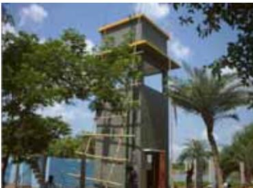
*Fig. 73.1-Primeira Estação de Tratamento de Água usando o Sistema de Filtração Lenta em Areia (Tratamento Ecológico) construída no Bangladesh. Trata-se de uma pequena instalação que abastece aproximadamente 1.500 pessoas e é composta por: torre de captação de água, pré-tratamento e tratamento ecológico. As explicações sobre fundamentos do tratamento à população são assimiladas e auxiliam na administração da Estação.*
