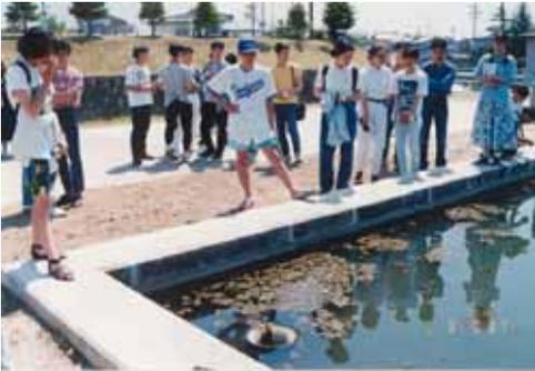
*Fig. 11.1-No tanque de filtração da Estação de Tratamento de Água de Ueda, encontram-se algas flutuando na superfície da água. Elas produzem oxigênio, o que torna o ambiente favorável à atividade de diversos organismos vivos. aparentemente, a sua presença é vista como indesejável, mas, ao contrário, elas desempenham um papel importante no processo de purificação da água.*
