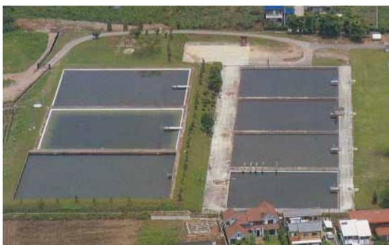
*Fig. 12.2-A foto da Estação de Tratamento de Água de Kenzaki, da cidade de Takasaki. Desde 1910, a estação fornece água de boa qualidade. A Estação simplesmente capta a água bruta, que passa por sedimentação e é filtrada lentamente através da areia.*
