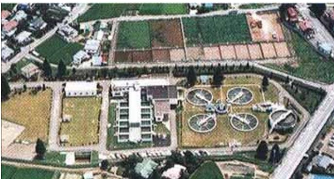
*Fig. 9.1-Foto da Estação de Tratamento de Água da cidade de Ueda, que usa Sistema de Filtração Rápida. As áreas de formato retangular são os locais onde os sedimentos produzidos estão em processo de secagem ao sol. As áreas quadradas destinam-se a 12 (doze) tanques pequenos de filtração, 4 (quatro) tanques circulares de sedimentação e 1 (um) tanque para mistura de produtos químicos. Embora a área ocupada pelos tanques de*
