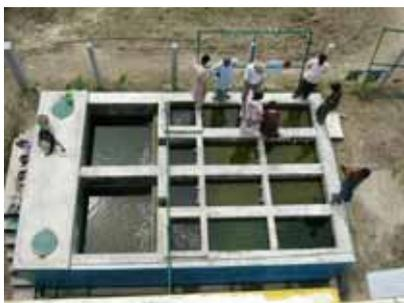
*Fig. 73.3-O sistema consiste em dois conjuntos de filtros com propósito de manutenção. Cada conjunto contém cinco filtros com cascalho grosso e um tanque de filtração lenta. Essa planta está projetada para produzir 15 m<sup>3</sup> de água potável por dia, mas sua capacidade máxima pode chegar a 30 m<sup>3</sup>. A*
