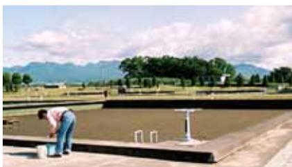
*Fig. 59.1-Na Estação de Tratamento de Água de Wakata, Província de Gunma, a água captada do rio, após ficar em repouso por cerca de doze horas no tanque de precipitação, é transferida ao tanque de filtração. A raspagem da camada de areia do filtro é realizada todos os meses, regularmente. Durante o verão, a atividade dos seres vivos é grande, mesmo com a filtração sem interrupção, não se verificando o*
