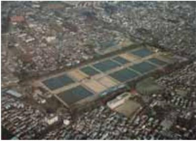
*Fig. 77.1-Estação de Tratamento de Água de Sakai, em Tóquio, é a maior estação que utiliza o Sistema de Filtração Lenta em Areia. Somente a instalação com tanques de filtração é suficiente.*
