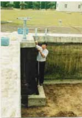
*Fig. 54.1-Tanque de filtração com 1,8m de profundidade, que tinha como finalidade impedir o crescimento de algas.*
