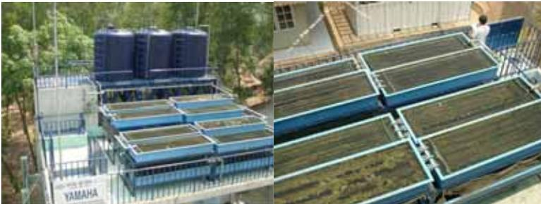
Fig. 72.2-Água captada passa por processos de pré-tratamento em vários tanques onde as colônias de seres vivos atuam removendo matérias em suspensão. Nos tanques que são instalados na laje da casa, crescem algas e microorganismos que capturam impurezas e as depositam no fundo do tanque.
