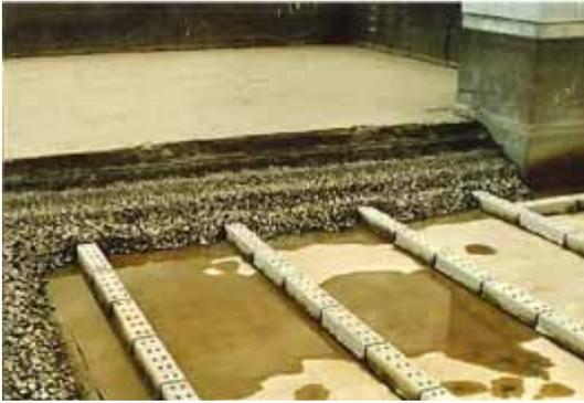
*Fig. 27.1-A foto mostra a secção do tanque de Sistema de Filtração Lenta em construção. Nota-se que as areias do meio filtrante são constituídas de diferentes granulações. Atualmente, o meio filtrante utilizado é mais espesso.*
