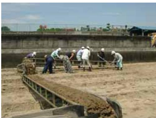
*Fig. 58.2-O trabalho de limpeza do tanque de filtração lenta pode ser executado por pessoas não especializadas. As areias removidas na limpeza poderão ser reutilizadas após a sua lavagem.*
