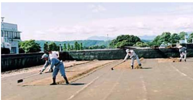
*Fig. 58.1-A entrada de água barrenta no tanque de filtração provoca o entupimento do filtro, razão pela qual, de vez em quando, é necessário o esvaziamento do tanque, para remoção do lodo acumulado na superfície da camada de areia. A camada a ser raspada deverá ser a menor possível. Embora a superfície da areia do filtro esteja aparentemente suja, esta deverá ser mantida com um pouco de água,*
