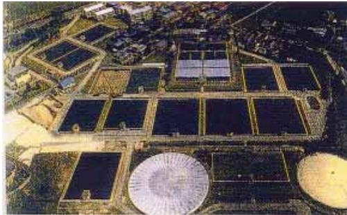
*Fig. 8-Estação de Tratamento de Água Someya, da cidade de Ueda, em 1984 (Foto cedida pela Prefeitura de Ueda). Os tanques de filtração ocupam a maior parte da área da Estação sendo desnecessárias outras instalações.*
