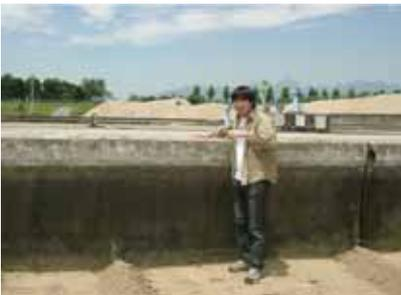
*Fig. 55.1-O tanque de filtração que a profundidade foi reduzida. Na superfície do meio filtrante, as algas crescem com vigor e as partículas de impurezas não conseguem penetrar na camada de areia, dificultando o entupimento.*
