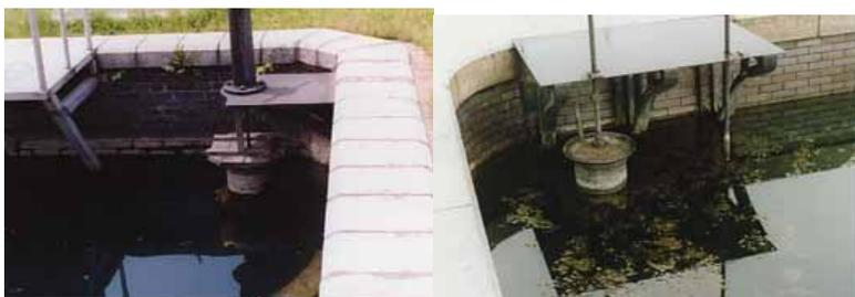
*Fig. 43.1-Tanque de filtração, onde o escoadouro encontrava-se fechado, impedindo que as algas saíssem. Os técnicos achavam que o escoadouro gerava desperdício de água captada. Na época, a idéia de “água poluída” era relacionada com o crescimento de algas.*
