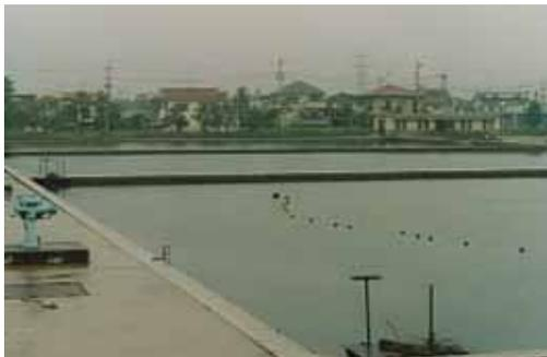
*Fig. 42.1-Departamento de Água de Tóquio, onde eram realizadas experiências sobre adição direta do cloro no tanque de filtração lenta. Matando-se os organismos vivos, estava eliminada a possibilidade de haver Tratamento Ecológico.*
