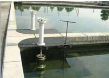
*Fig. 85.1-Algas flutuantes são facilmente descartadas através de canal de descarte móvel vertical.*
