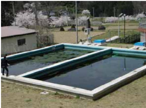
*Fig. 79.3-Estação de Tratamento de Nishibara, na Cidade de Suzaka, que capta água do manancial e a trata por filtração lenta. Cada tanque de filtração mede  $6,8m \times 13,5m = 91,8 m^2$ . No tanque de filtração crescem algas; elas saem automaticamente pelo canal de descarte e são despejadas no rio. Dessa forma, é possível ficar mais de um ano sem nenhuma manutenção.*
