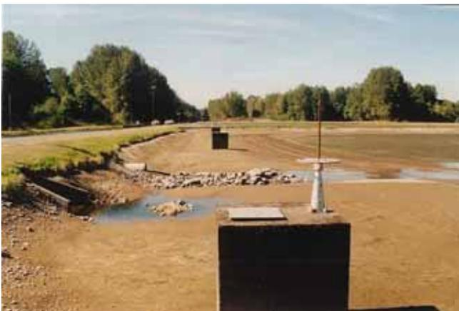
*Fig. 76.1-Estação de Tratamento de Água por Sistema de Filtração Lenta em Areia da Salem - EUA, localizada no subúrbio da cidade. É uma simples lagoa natural circundada por barragem. A terra nesses locais é barata.*
