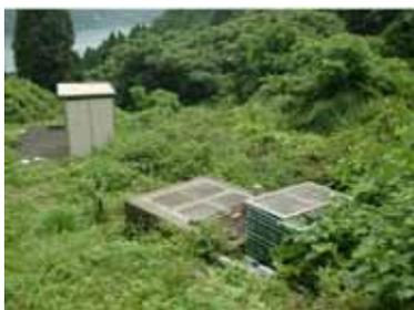
*Fig. 86.2-A água de mina captada passa por pré-filtração e, posteriormente, por Filtração Lenta em Areia. O meio filtrante é coberto por camadas de feltro. Essa instalação pode abastecer cerca de 100 pessoas.*
