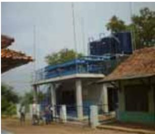
Fig. 72.1-Sistema de Filtração Lenta que fornece água potável para 2.000 pessoas na Indonésia. Esse sistema é administrado pela própria comunidade local e funciona há seis anos, sem problemas.
