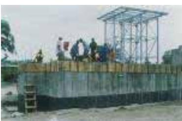
*Fig. 75.3-Construção do tanque de filtração*
