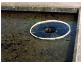
*Fig. 83.1-Para evitar a saída das algas que flutuam através do canal de descarte, construiu-se uma rede de malha circular.*
