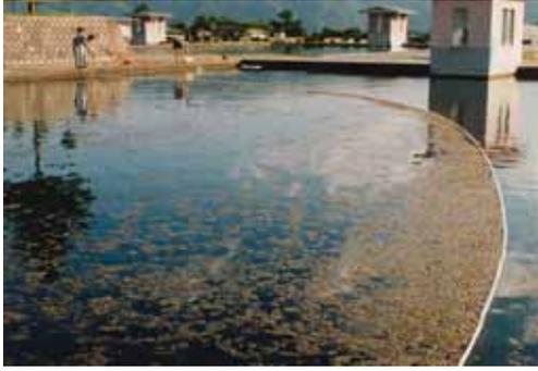
*Fig. 83.2-As algas diatomáceas que flutuam são coletadas por uma rede (malha de 1cm e 50cm de profundidade), feita manualmente.*
