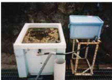
*Fig. 88.1-A banheira de ofurô, em vista lateral, permite o uso de até 2,5m<sup>3</sup> de água potável por dia, o que equivale ao consumo de sete pessoas, pelos padrões de consumo no Japão.*
