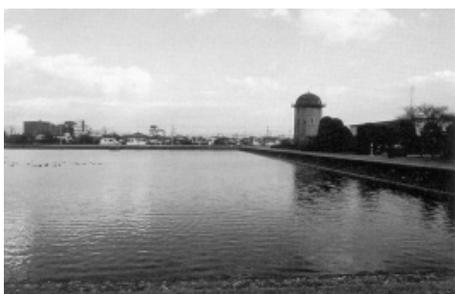
*Fig. 51.1-A água do rio Kiso é captada e levada para o tanque de precipitação de Toriimatsu, onde é armazenada por 1 a 2 dias, para que as partículas de suspensão sejam decantadas. Durante o verão, crescem os fitoplânctons.*
