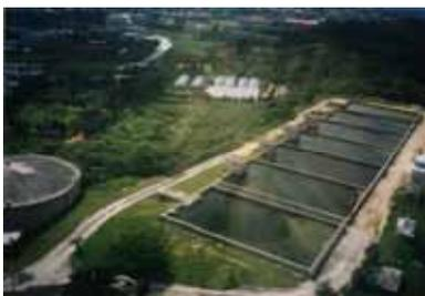
*Fig. 82.2-Estação de Tratamento de Água da Sodeyama, em Okinawa. A ilha, de formação calcária, capta água do subsolo. Por isso, a instalação só precisa de tanque de filtração e de distribuição de água potável. Ao pesquisar esta Estação, foi possível compreender o Tratamento Ecológico nas regiões tropicais.*
