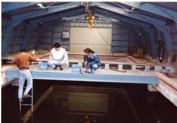
*Fig. 57.2-No Japão, nas regiões frias, existem tanques de filtração cobertos, mas os mesmos entopem facilmente.*
