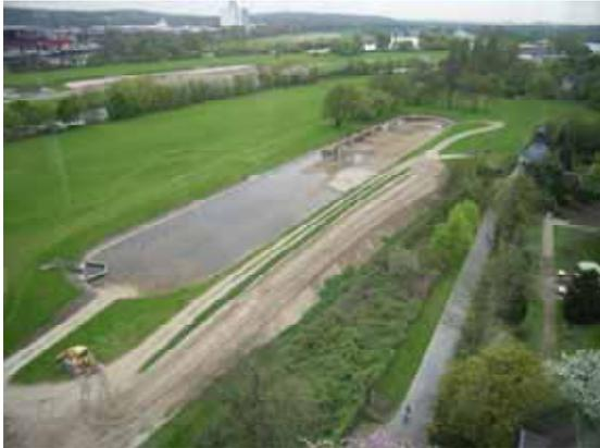
*Fig. 79.1-Processo de filtração em dique, na Estação de Tratamento de Muruhaimm na Alemanha, onde a água do Rio "Ruru" era desviada até um tanque raso, sendo produzida, artificialmente, água com qualidade semelhante à da encontrada em nascentes. Por meio de uma tubulação, essa água é recalçada e distribuída à população.*
