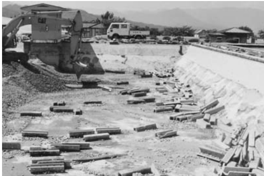
図 77. 建設し 70 年以上も使っていたので、ろ過池が古くなったので、ろ過池更新をするという工事をした浄水場があった。このろ過池の壁は、斜めで、生物繁殖の調子が良かった。単に古いという理由だけで、作り替えるような無駄使いが行われていた。しかしながら、欧米では 100 年以上使い続けて問題が無いろ過池は多数ある。
