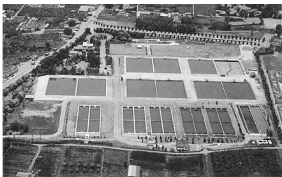
図 87. キンビール工場へ送水していた若田浄水場。濁り対策で凝集剤を使用する設計であったが、凝集剤を使うとキンビールが使ってくれないので、凝集剤を一切使わないようにしていた。
