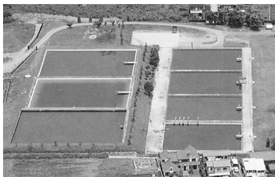
図 86. 明治時代、日本に急速ろ過による浄水場が建設される前から現在まで現役で稼働し続けている高崎市剣崎浄水場。河川表流水を取水するが濁り対策では、沈澱池である。
