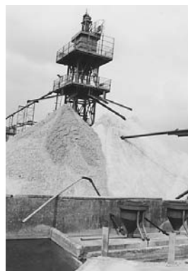
図 40. 英国テムズ水道のアッシュフォードコモン浄水場の洗砂後の砂の山。近くに行くと、緩速ろ過の砂は、日本のより粗く大きかった。しかも、砂はそんなに均一でない。緩速ろ過処理は、砂でのろ過でなく、砂の表面、砂の間の細菌と微小動物が活躍して浄化する。砂の大きさは関係なかった。
