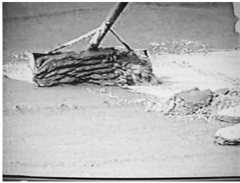
図 64. 砂層表面の削り取り作業。茶色の砂層は除かないようにするのがコツ。浄化の主役は砂層上部で活躍する微小動物であるので、除かないようにするのが正解である。
