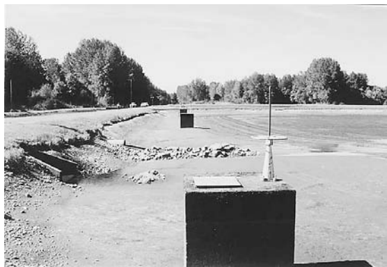
図 41. アメリカのオレゴンの緩速ろ過の研修で、緩速ろ過池を見て驚いた。周囲の壁は、まるで水田やため池みたい。水深も浅く、周囲は土手のまま。砂は日本の標準より細かった。アメリカは、急速ろ過の本場。緩速ろ過は、細かな砂での機械的ろ過に大きく期待しているようだ。
