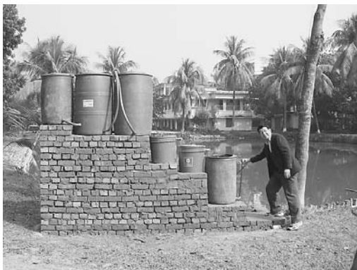
図 39. バングラデッシュのジョソールの公衆衛生局の事務所の中庭に、生物浄化法のモデルを作成した。池の水を汲み上げて浄化する。停電も頻発するし、電気代がもったいないから、3つの原水貯留槽、上向き粗ろ過槽が2槽、最後が緩速ろ過槽。
