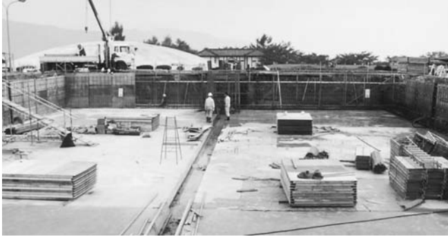
図 80. 斜め壁のろ過池に比べると、垂直壁のろ過池では、藻類繁殖が悪く、浄化機能が発揮するのに日数がかかった。それは、斜め壁だと、浅い部分で藻類が繁殖し、微小動物が繁殖する。それらが種となり、底に落ちて、浄化機能が発現したと考えられた。しかし、この浄水場では、斜め壁のろ過池を浄化機能が悪い垂直壁のろ過池構造に更新してしまった。生物群集の活躍による浄化が基本という思想が生かされていないのが残念である。
