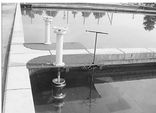
図 85. 越流管の重要性、連続培養の重要性は、日本各地で認識されだした。上下可動式の越流管も設置されているところがある。
