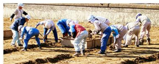
ろ過水は約10日で非常に清澄になった。生物群集が活躍している砂層表面を取り除いてはいけない。 The filtrate rapidly became very clear after 10 days after a scraping. This means "Don't scrape the surface biological active layer".
