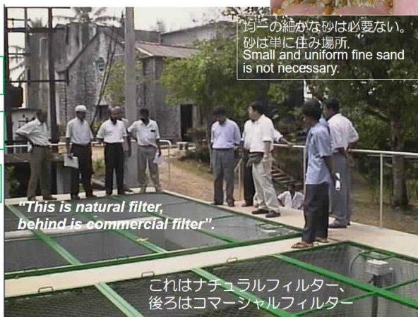
図 24-1 沈殿＋3 段の上向き粗ろ過、砂ろ過は粗い砂を用いた
