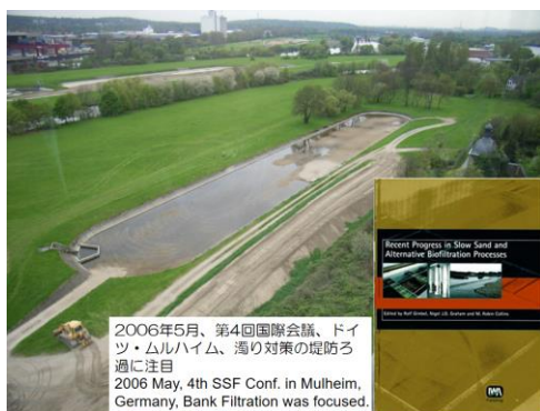
図 10-4 第 4 回国際会議はドイツ・ムルハイムで 2006 年で開催。濁り対策で人工の伏流水（堤防ろ過 Bank Filtration）が薬を使わない方法として注目された。
