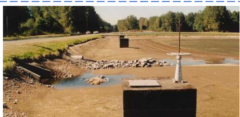
コラム②: セーラム市の緩速ろ過池。ろ過水の 水質が良ければどんな構造でも良かった。 Slow Sand Filter in Salem city, Oregon, USA.
