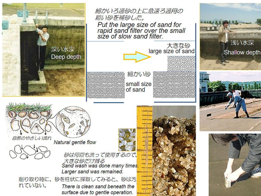
図 16-1 生物群集の活性を高めるために、深い水深を浅くした。大きな砂を補砂しても砂層へ汚れが入っていなかった。
