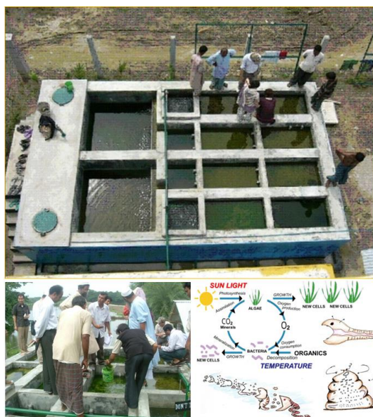
図 25-2 農薬などの難分解性物質の生物分解を徹底するため上向き粗ろ過で藻の繁殖、動物による分解を4回繰り返した。
